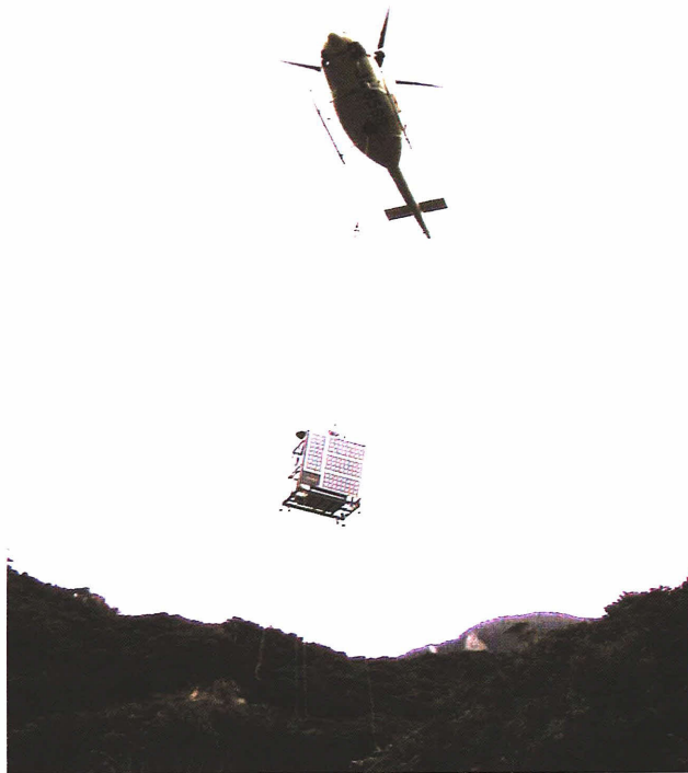
写真－5 ヘリコプターによる設置作業 新島「M阿土山」
