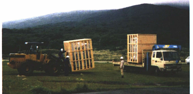
写真－6 架台搬入 三宅島「三宅空港」
