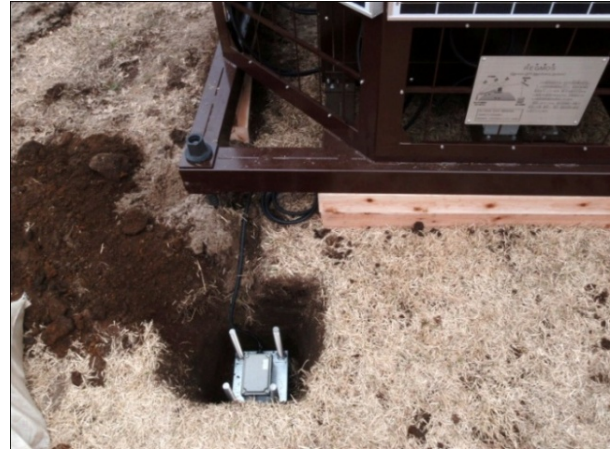
写真-4 傾斜計（地中）の設置
