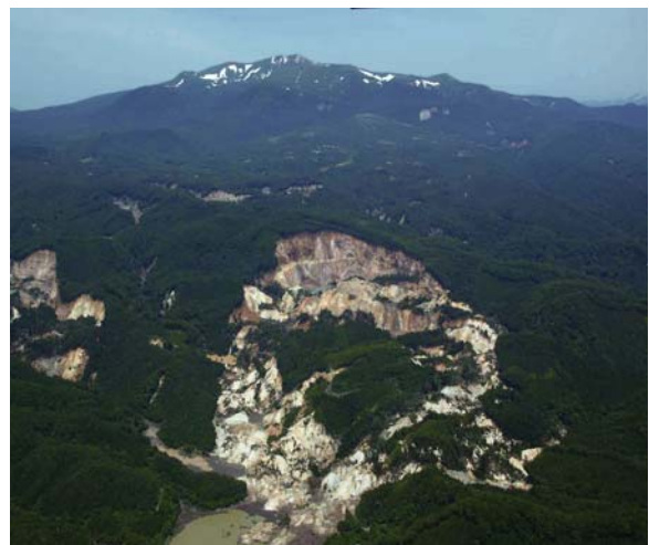
写真-1 荒砥沢ダム北方の大規模地すべり。左下は荒砥沢ダムの水部、背後に栗駒山を望む。（2008年6月 八木浩司撮影）
