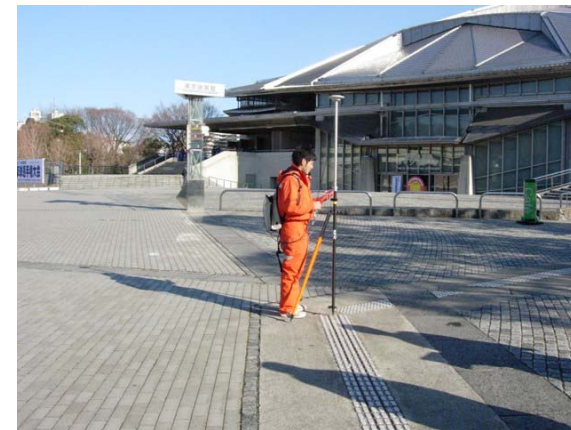
2010. 1. 13RTKによる測量の様子
