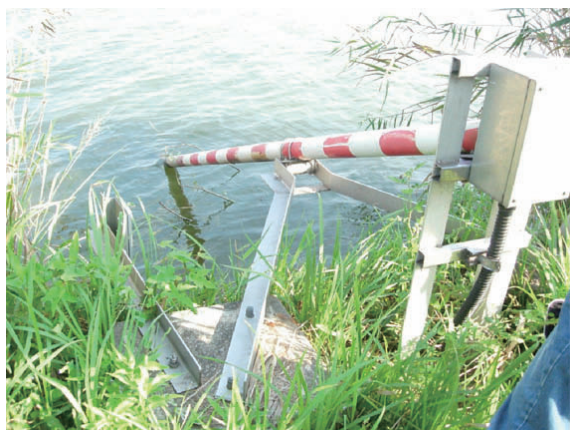
写真-17 木場潟水位観測所
