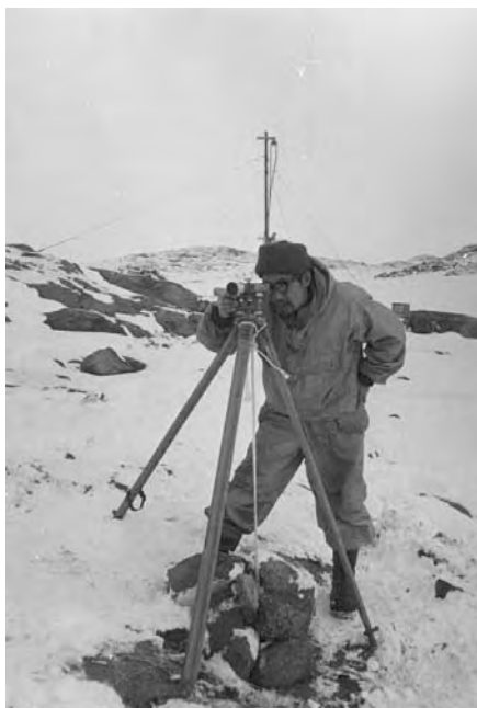
写真-10 ヤルトオイ島における簡易験潮(第12次観測隊) (上): 海中に立てた標尺, (下): レベルによる観測
