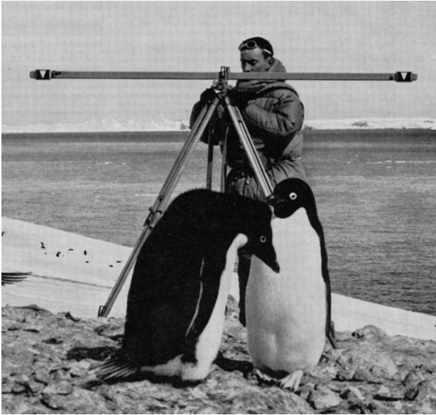
写真-1 ウィルド社製2mサブテンスバー (ライカ社カタログより)
