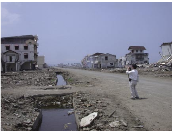
写真-6 市街地西部の被災状況 (西側を望む)
