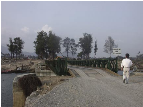
写真－11 仮復旧したロンガ南方の国道橋
