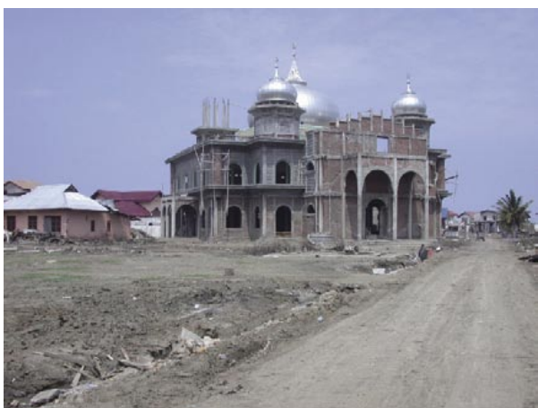
写真-18 モスクはその構造ゆえ被災を免れたものが多く、地域住民の支えとなっていた。 避難・復興拠点整備への鍵となるかも知れない
