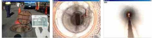
以上の内容を目視確認し、必要に応じて写真撮影を行い、最終的な調査記録を下水道施設平面図上に表示するといった業務です。
