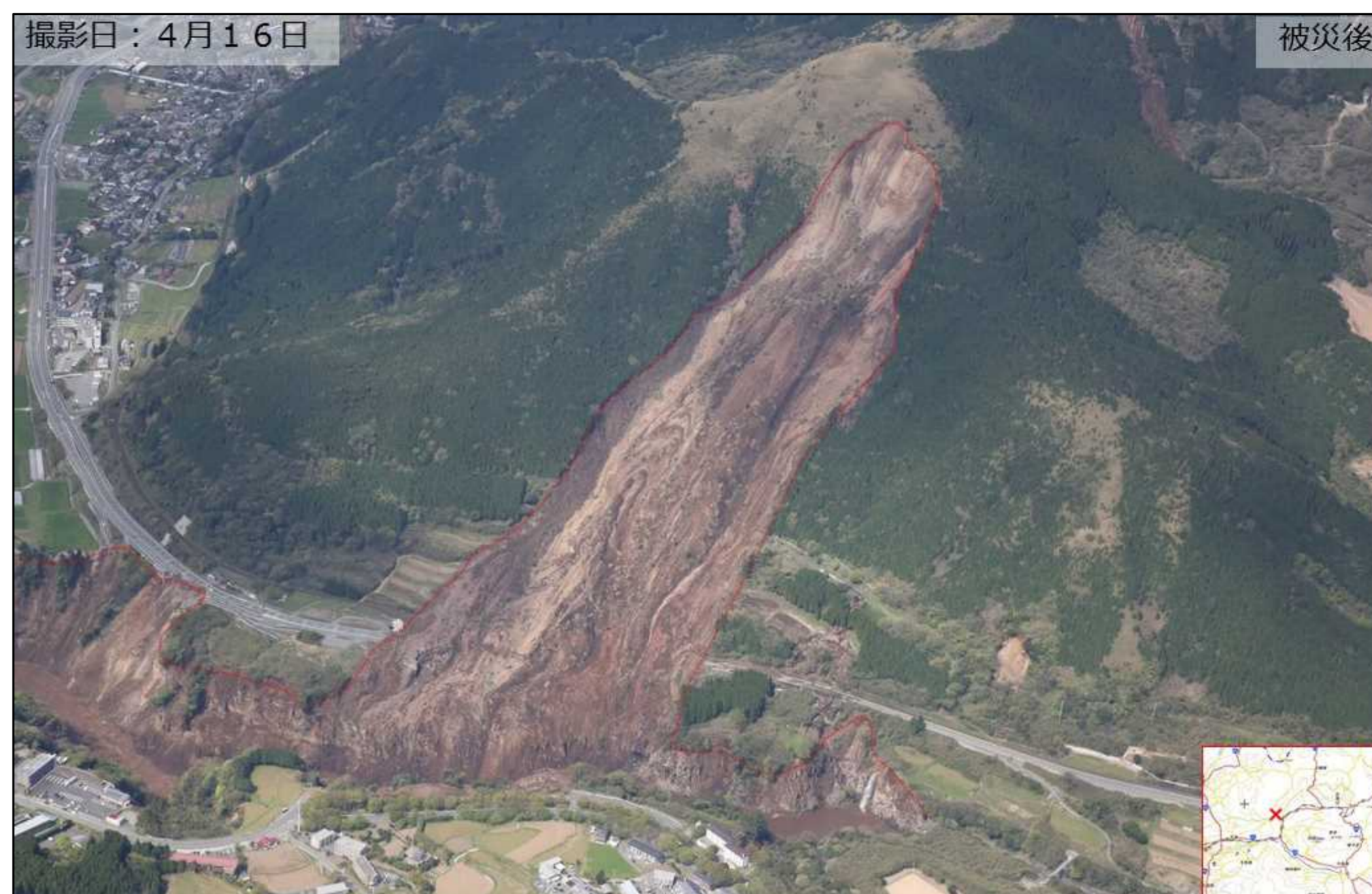
土砂災害（阿蘇大橋周辺）（2016年(平成28年)4月16日撮影）
