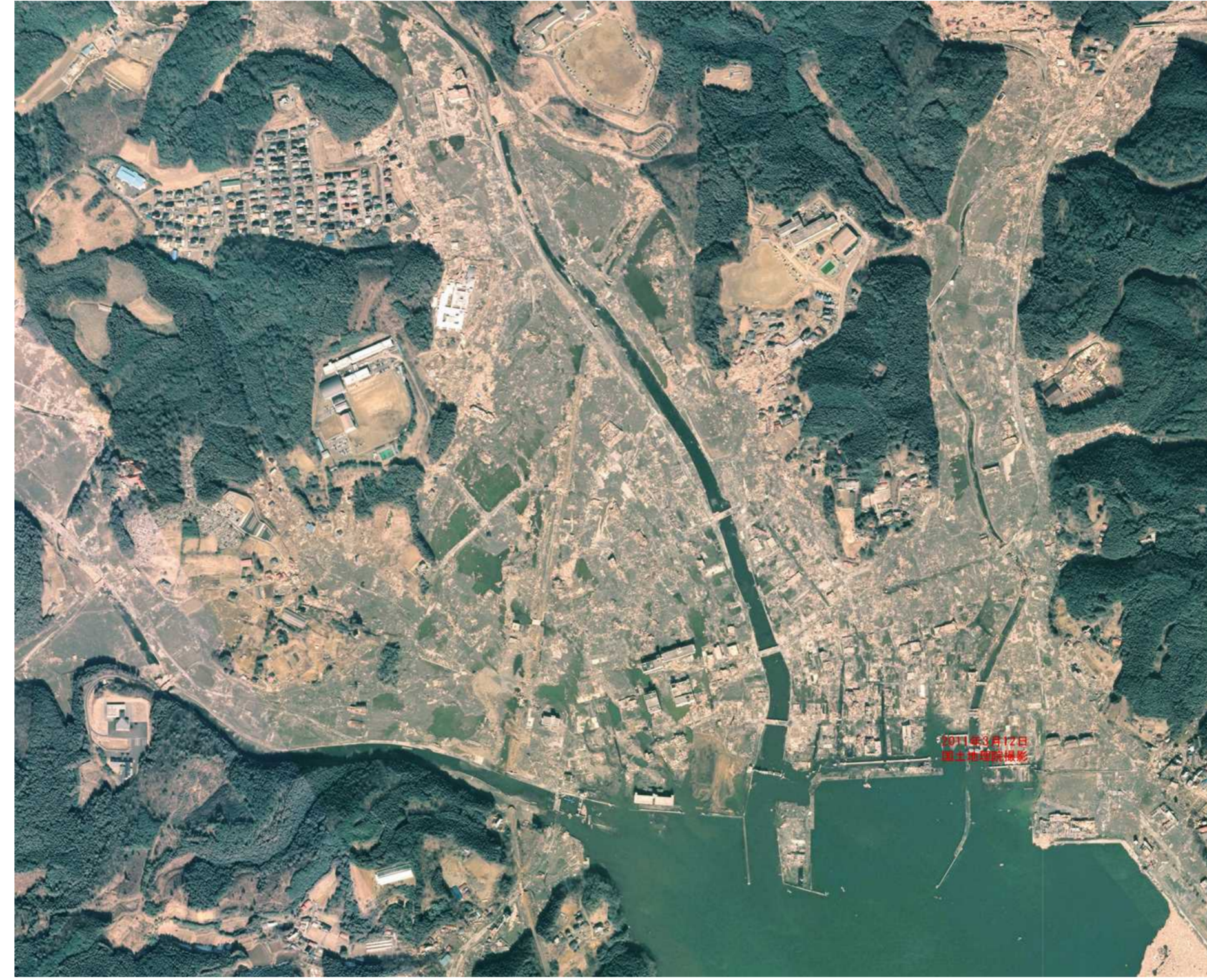
地震後(2011年(平成23年)3月12日撮影) 南三陸町(志津川漁港)
