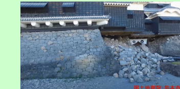
熊本地震による建物被害 (熊本城)
