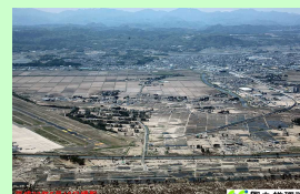
東日本大震災による津波被害 (仙台空港)
