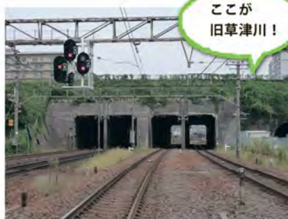
写真 1-8 地点1を地上から見たところ
