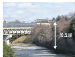
写真1-5 段丘崖に入る圏央道のトンネル
