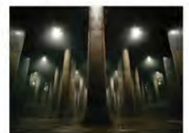
写真 2-7 首都圏外郭放水路の調圧水槽 (国土交通省江戸川河川事務所より引用) 水の勢いを弱めるための調圧水槽。広々とした空間に柱が並ぶ光景から、「地下神殿」と呼ばれています。
