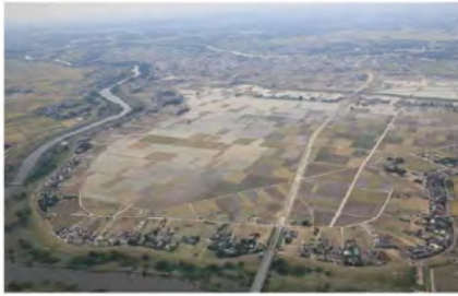
写真1-13 平成27年9月関東・東北豪雨で、鬼怒川決壊により浸水被害を受けた場所 洪水から6日経っていますが、後背湿地のため水が引いていません。
