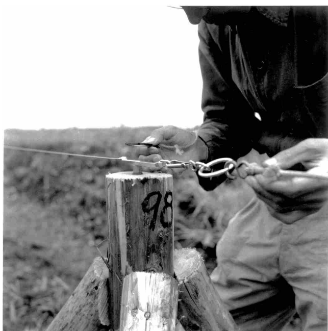
基線尺の読み取り 昭和28年（1953） 饗庭野基線
