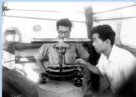
一等経緯儀(改造前)の観測風景 経緯儀の後の人は、目盛を読む専門の副手 (撮影年: 昭和20年代)
