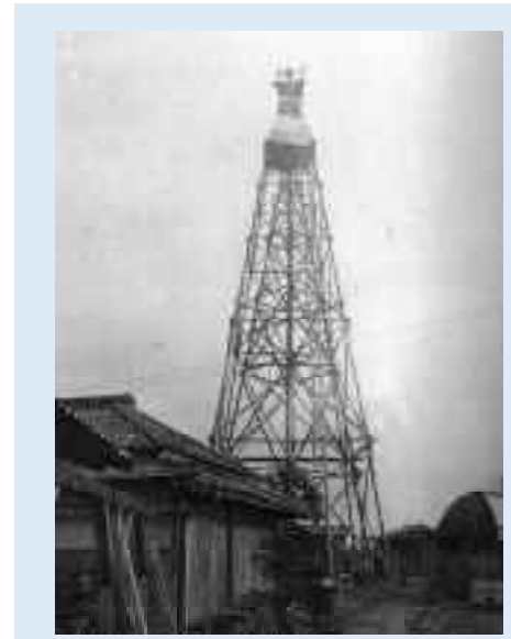
関東地震後の復旧測量で建設した懸柱式高測標 (大正13年造標、机板高26m)
