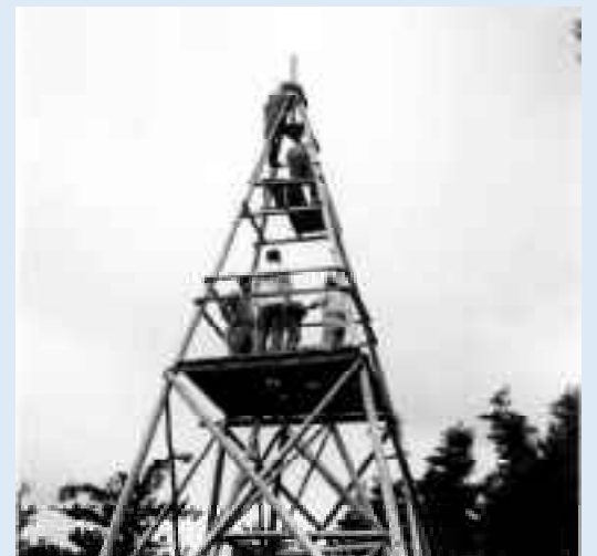
やぐらを建てる様子。職員は観測だけでなく大工仕事もこなす。
