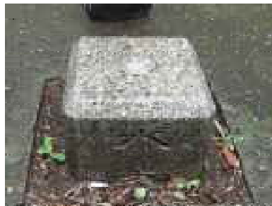
一等水準点「交3」 明治16年当時の標石、各角が切り落とされている
