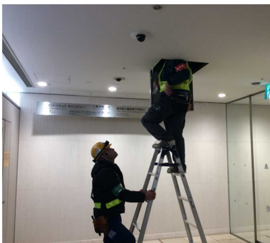
図 22: 天井付近に設置不可の場合の例
