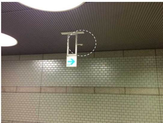
図 21: 他の設備への設置の例
