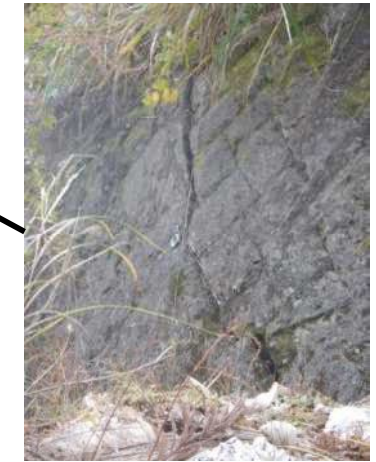
擁壁の開口亀裂と はらみ出し
