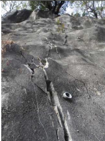
干渉縞下部(地すべり末端部)のモルタル被覆に幅数センチの新しい開口亀裂とはらみ出し
