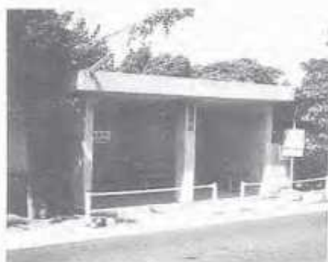
写真-24 避難壕（西南部赤水付近）
