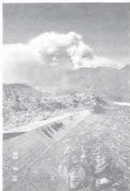
写真-26 導流堤（黒神集落付近）
