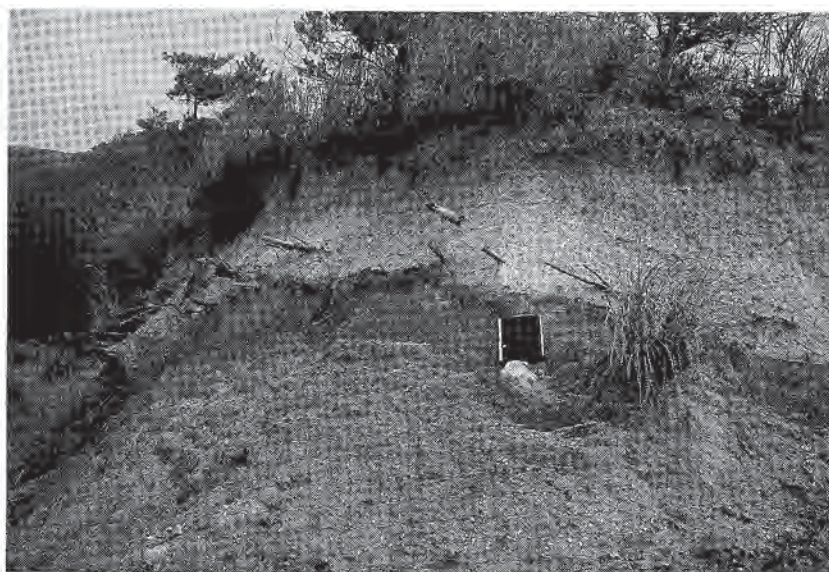
写真16 手洗温泉の露頭。下位の赤褐色の温泉余土と上位の白色の砂礫の間に、一方向に倒れて埋積した竹が見られる。これは、1971年の水蒸気爆発以前の地表面であると考えられる。
