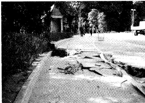
写真-2 水準点の北側に生じた亀裂(玉野総合コンサルタント株式会社提供)
