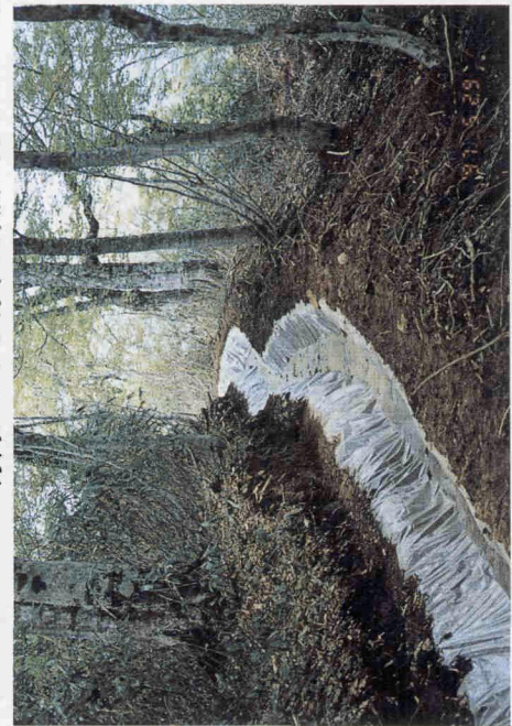
写真-2 湧水の地すべり地への流入を防止するための応急排水路 (1997年5月29日撮影)
