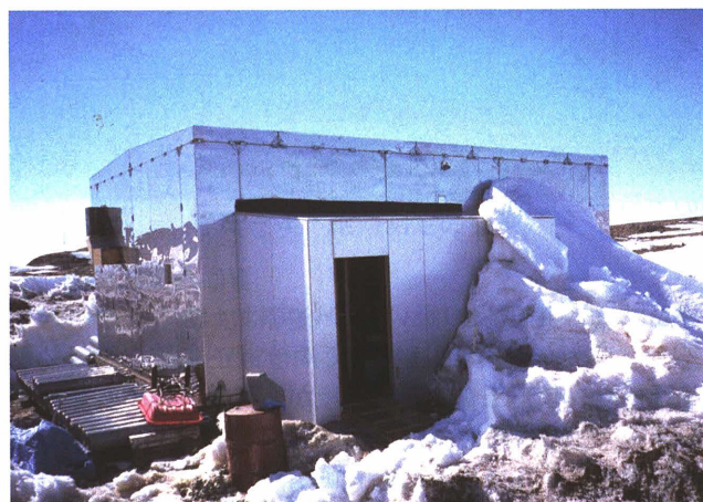
写真-1 昭和基地重力計室
