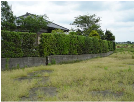
写真6 宅地ごと傾動している住宅
