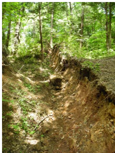
③地点の山間部に続く段差
