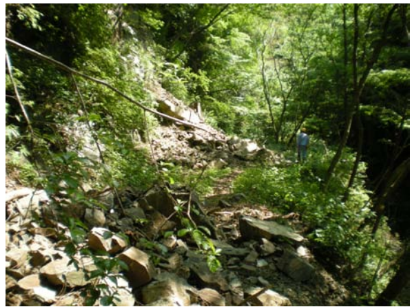
⑮地点の斜面崩壊多発地点 地質は御斎所変成岩 (緑色片岩)
