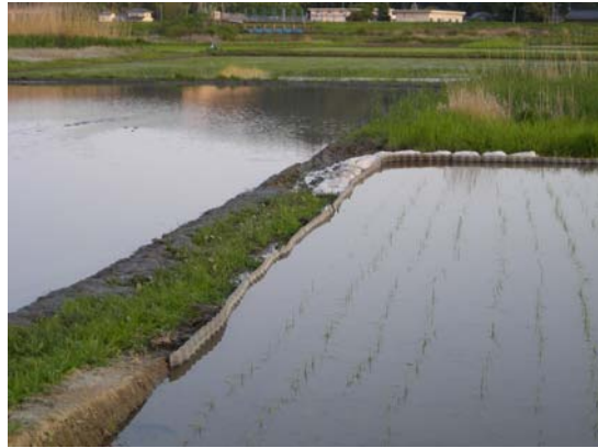
畔が不等沈下したので土嚢でかさ上げ
