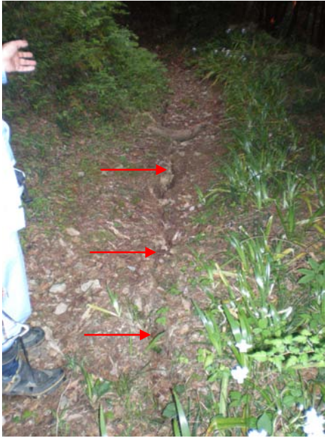
⑭洞坂地区では徒歩道に亀裂 長さ 10m 強 高低差 10cm
