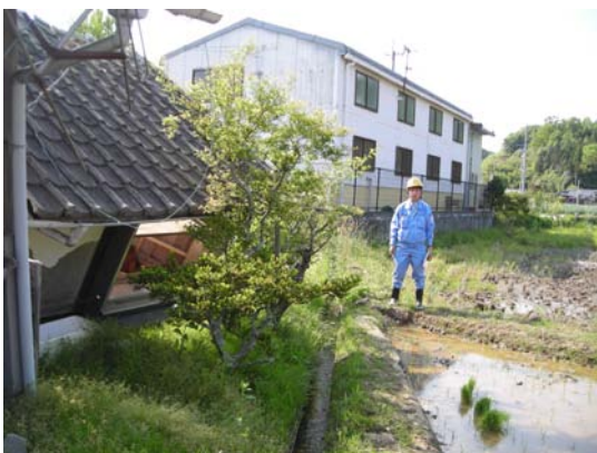
倒壊建物の地盤は水田と高さの差は無い
