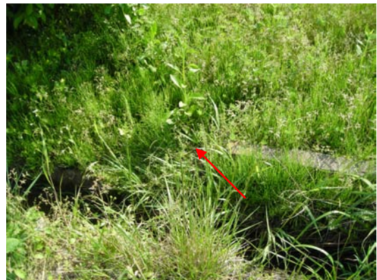
倒壊建物の地盤に不等沈下が認められる 側溝に約 10cm の沈下が認められる
