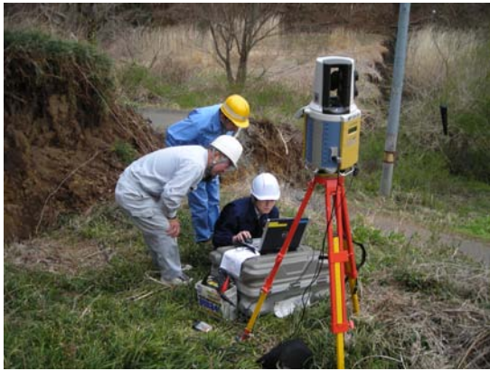
地上レーザー測量の様子
