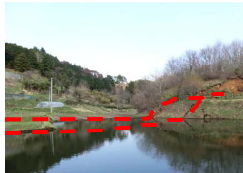
写真4 断層変位で水没した田
