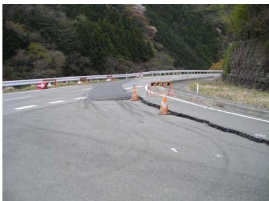
ほぼ南北方向に亀裂が入っている。北東側から撮影。東側が落ちている。
