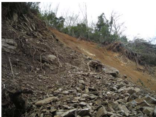
鮫川右岸の斜面崩壊。南側より撮影。崩壊深は1~2m程度でそれほど深くはない。
