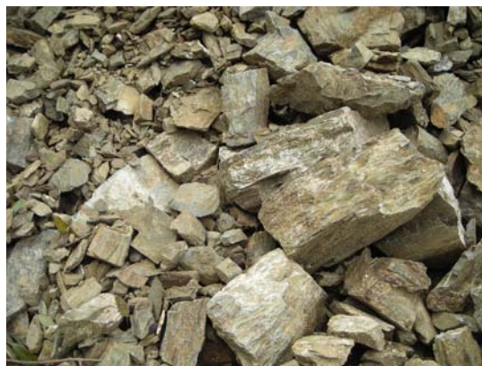
地質は緑色岩起源の片岩（御斎所変成岩）で、岩塊状に崩落している。
