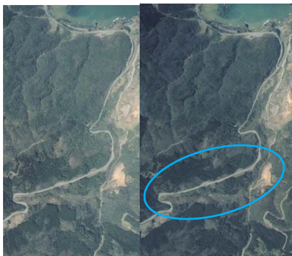
(b) 道路被害部分の空中写真
