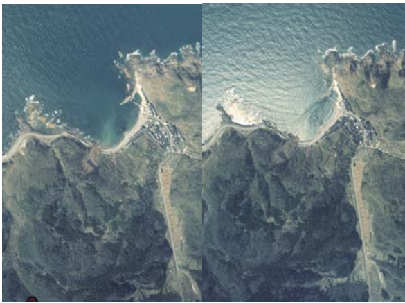
(b) 崩壊地の空中写真 (立体視可能)
