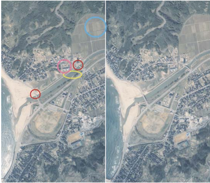
○ 路面の段差 ○ 液状化 ○ 堤防の破損 ○ 家屋倒壊
