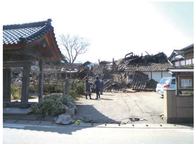
図-13 輪島市門前町における寺院の倒壊
