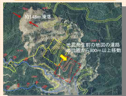
空中写真による被災状況の計測(H20 岩手・宮城内陸地震)
