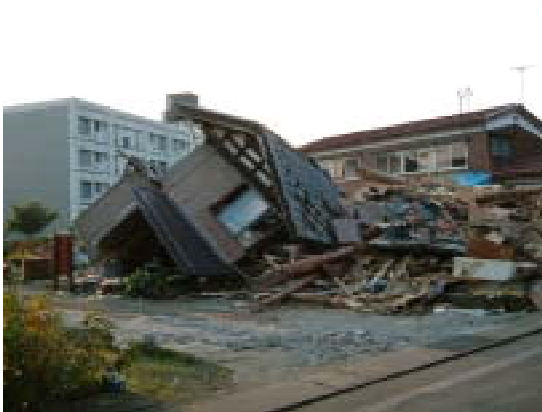
川口町川口の家屋倒壊
