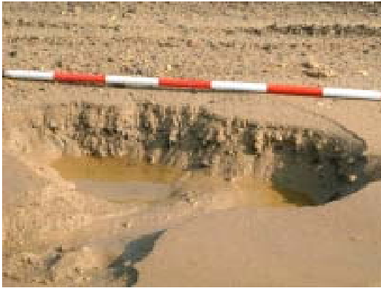
小千谷市高梨町付近の液状化
