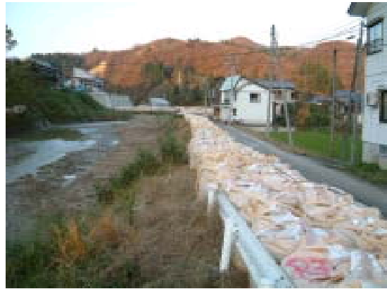
旧堀之内町竜光の芋川下流土石流防止用土嚢
