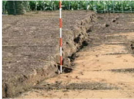
小千谷市高梨町付近の地割れ及び液状化
