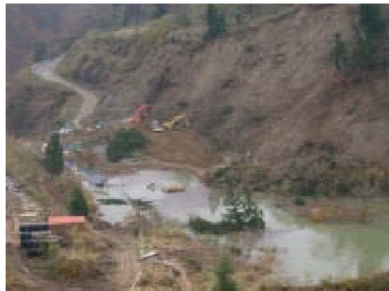
山古志村寺野の地すべりによる河道閉塞による湛水域
