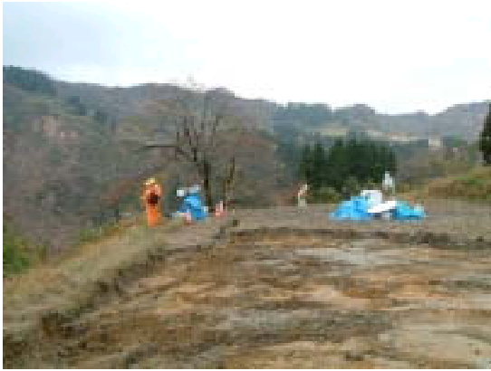
地方整備局が設置した河道閉塞による湛水域の定点観測カメラ
