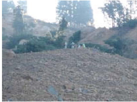
山古志村桂谷:羽黒トンネル上部の大規模地すべり
