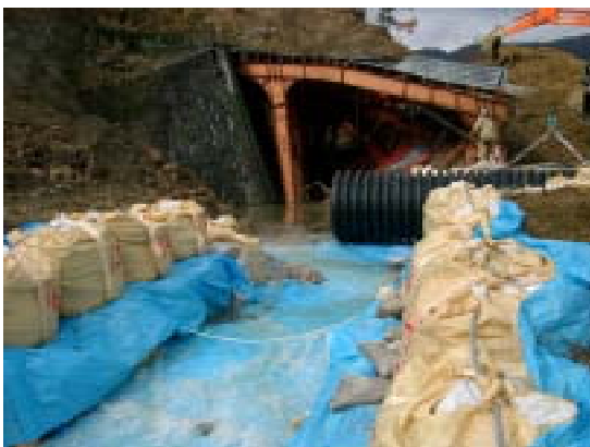
寺野の河道閉塞による湛水域の排水
