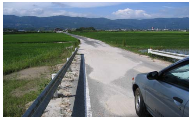
写真-15 えびの市亀沢地区土砂流
