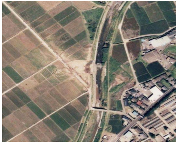
写真－8 水之手川右岸の堤防決壊（大口市原田付近）
