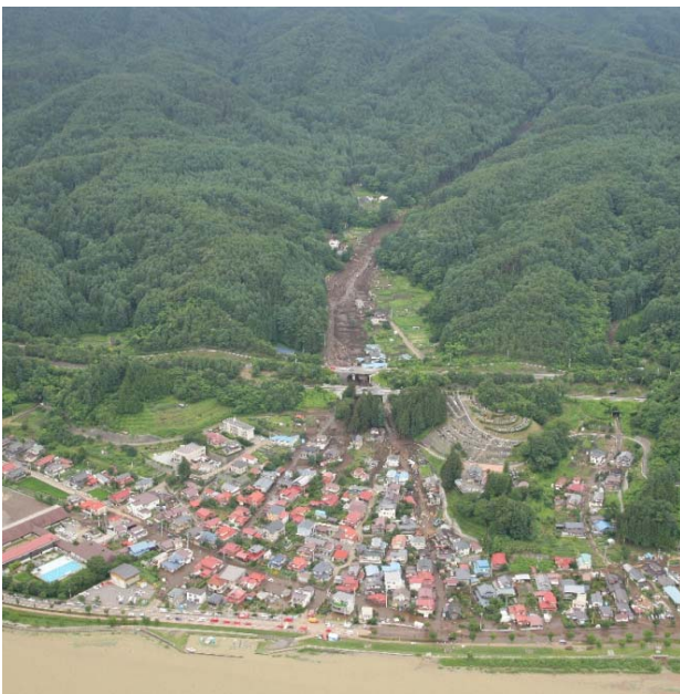
写真-3 湊地区の土石流, 撮影方向は図-7参照 (7月20日, (株)パスコ・国際航業(株)撮影)
