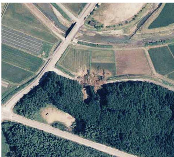
写真－7 斜面崩壊（菱刈町徳辺付近）
