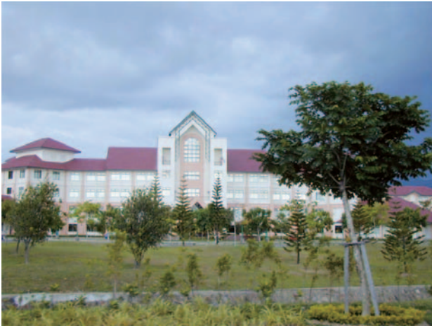
写真－6 SABAH 大学工学部校舎
