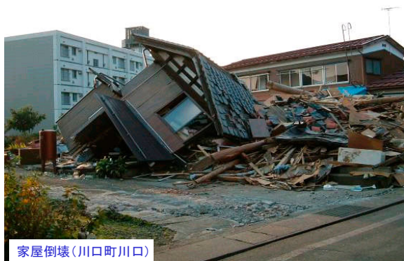
写真-3 家屋倒壊
