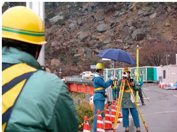
写真-12 崖崩れ現場付近での観測(小千谷市)
