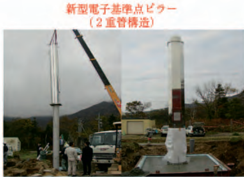
写真-1 2002年新型ピラー建設
