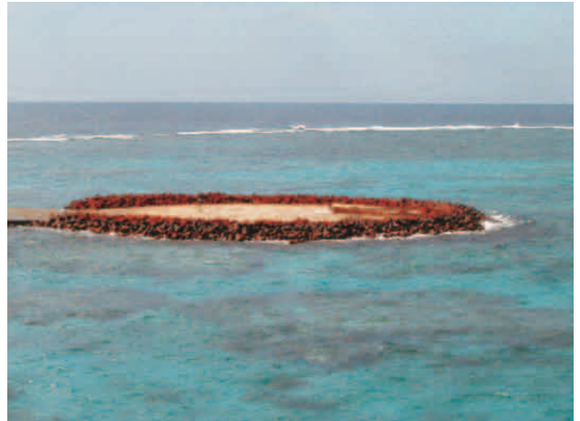
写真 - 5 観測所基盤 (旧灯台跡)
